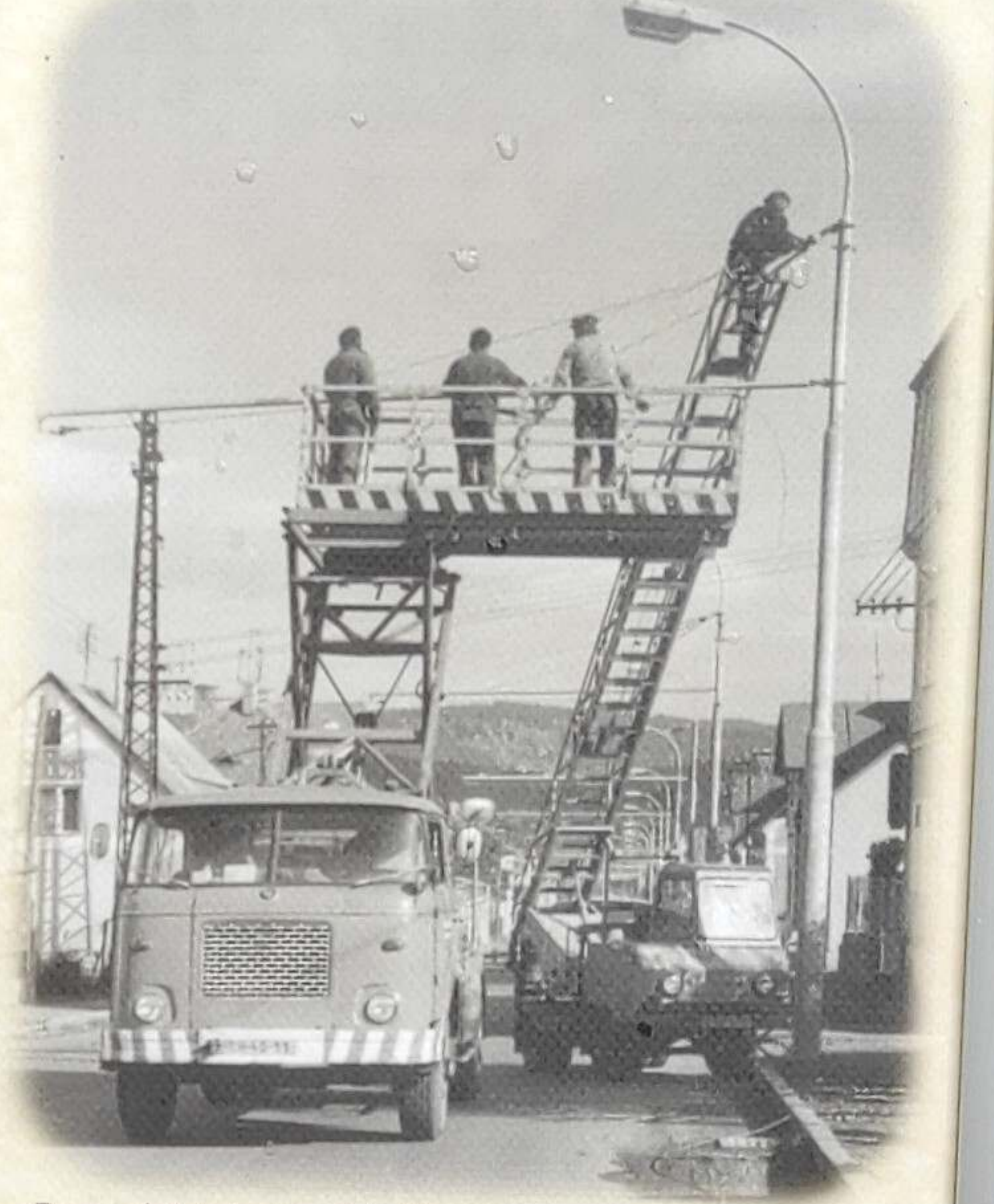
Pro výstavbu a údržbu trolejového vedení se používaly nejen montážní plošiny (zde Škoda 706 RTH - vpravo), ale i výsuvný žebřík Multicar M24 (vlevo). Snímek ze stavby trolejbusové trati ve Velké Hleďsebi.
