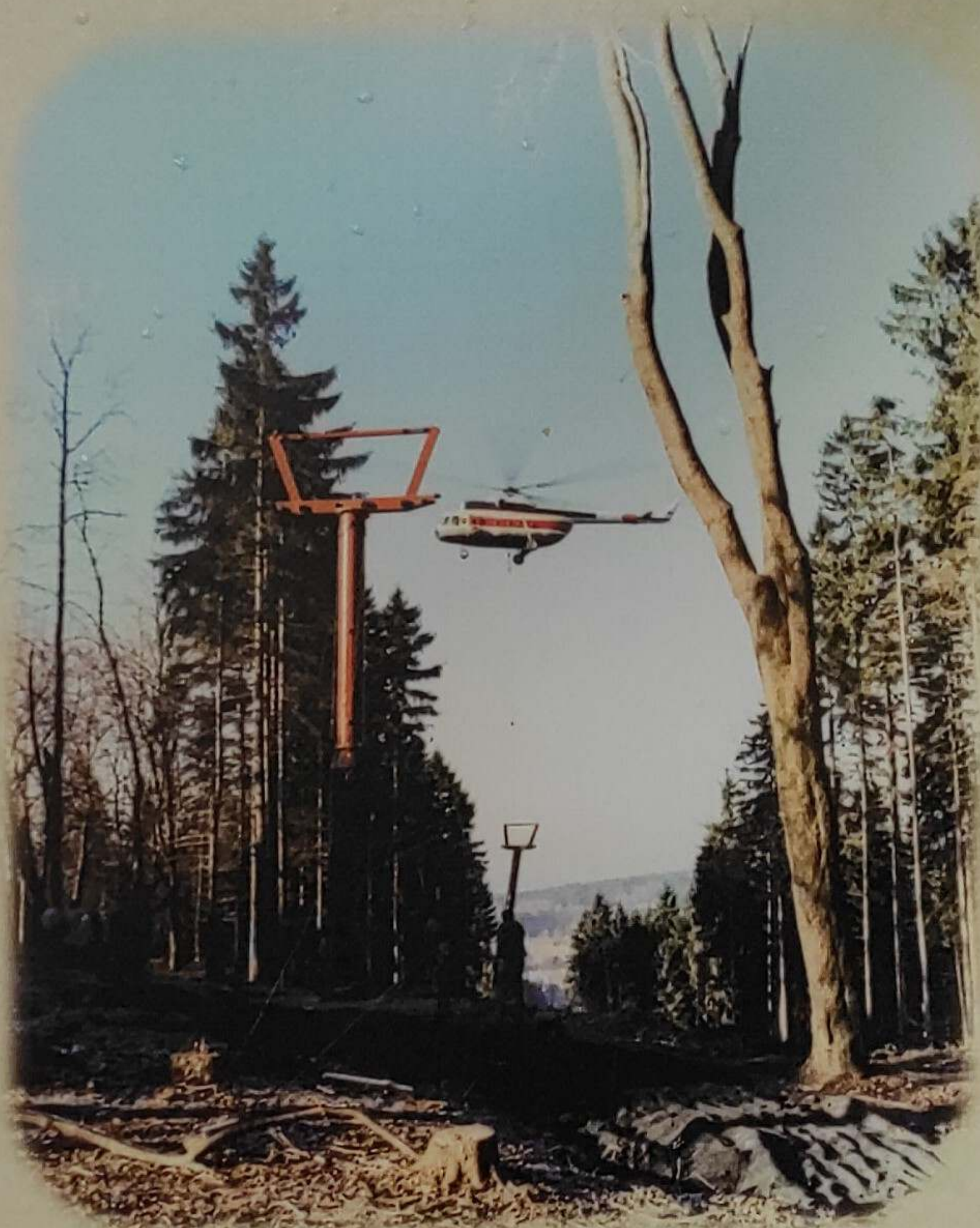
Při výstavbě podpěr lanové dráhy byl nápomocen vrtulník.
