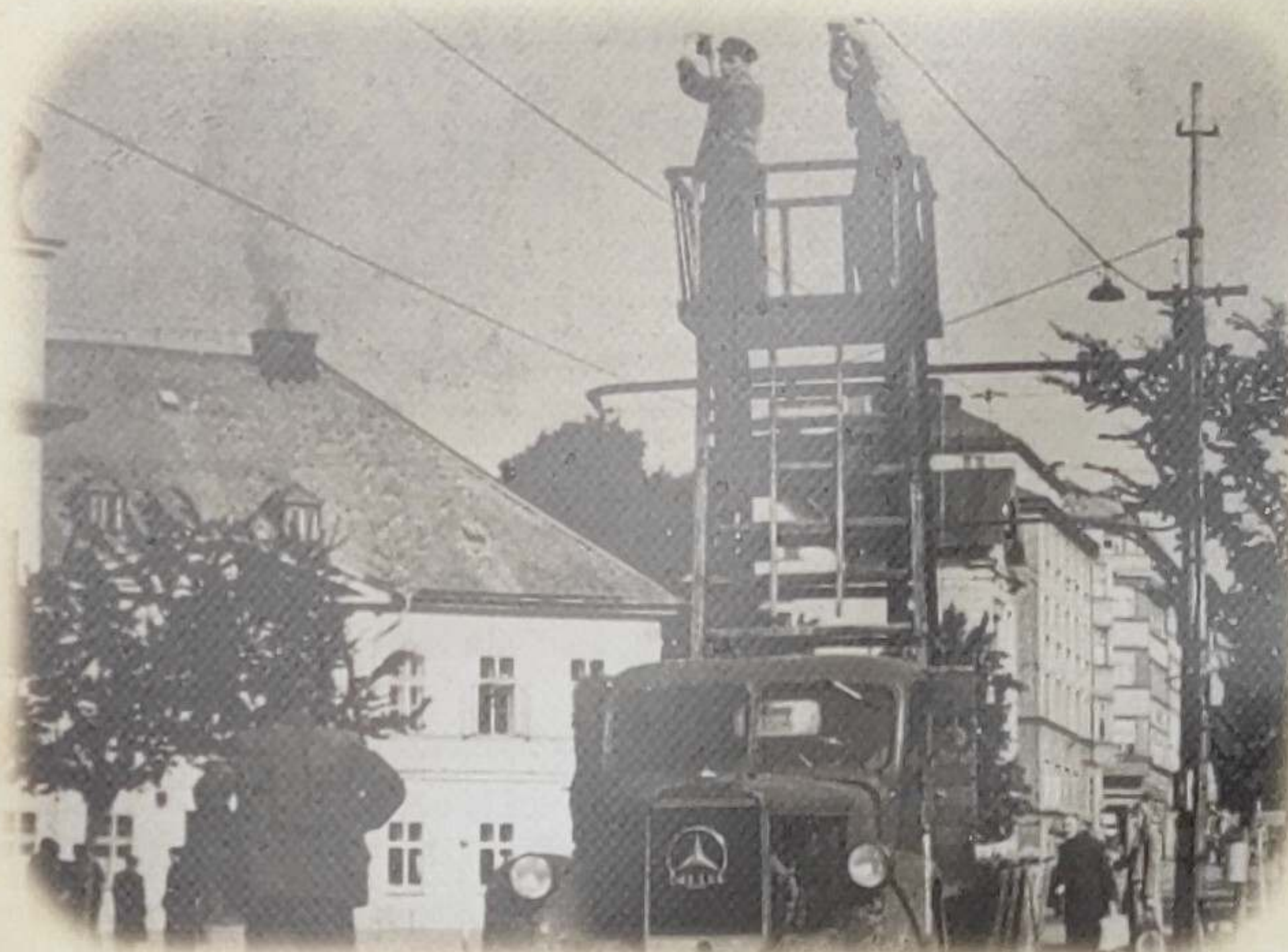
Výstavba trolejbusového vedení před Šumavou (Chebská křižovatka).
