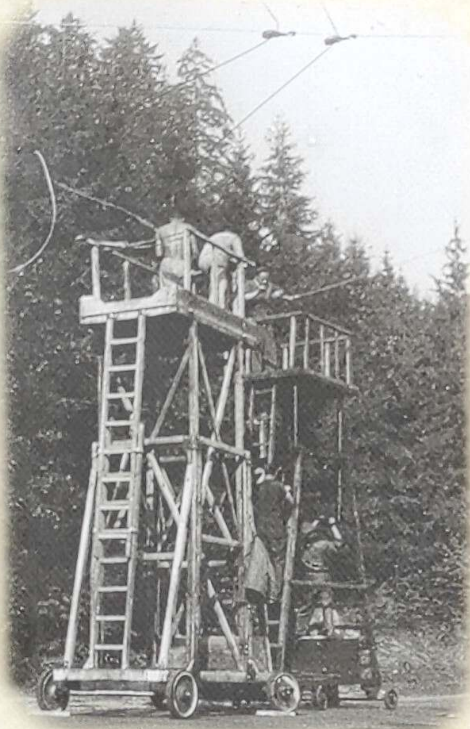
Obě dřevěné montážní věže při stavbě trolejového vedení u Lesního pramene.
