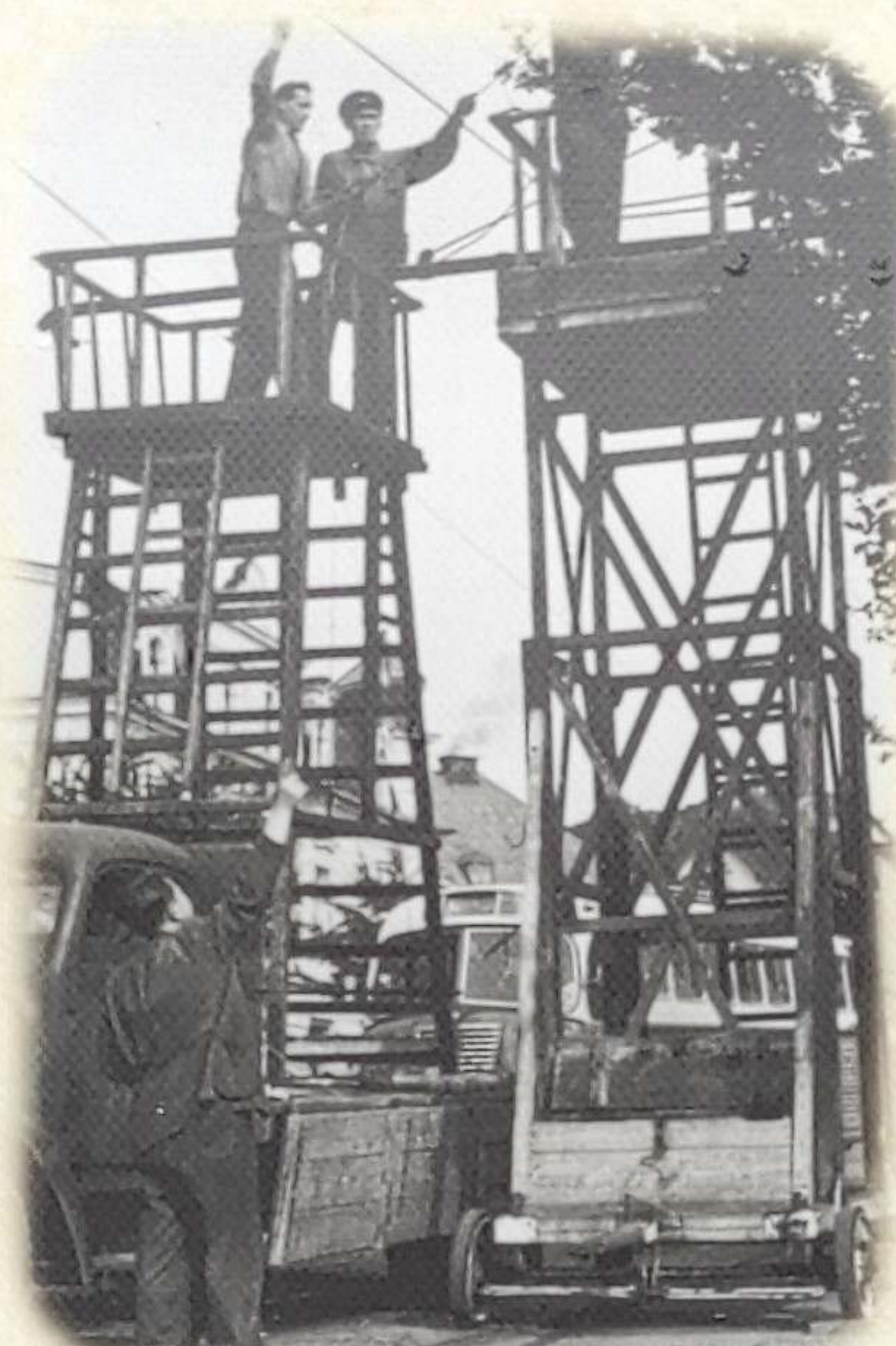
Dřevěná montážní věž (vpravo) a montážní plošina na nákladním automobilu Mercedes (vlevo) při stavbě první trolejbusové trati.
